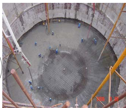
图 11-39 上海宝钢热轧旋流池圆筒形基坑
