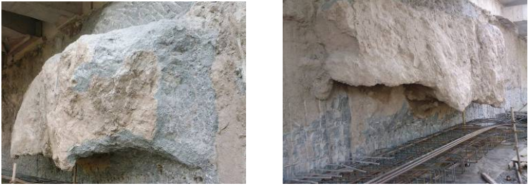
图 11-28 槽壁局部坍塌混凝土“鼓肚子”图片
