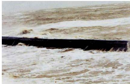
图15-23 渤海岸边钢筋混凝土板桩防浪堤
