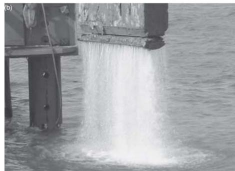
图15-18 板桩射水喷射方法
