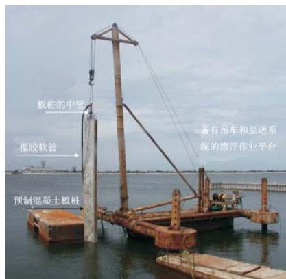
图15-17预制钢筋混凝土桩插桩
