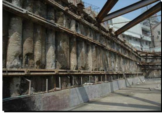
图 27-64 钻孔后注浆连续墙开挖侧壁效果
