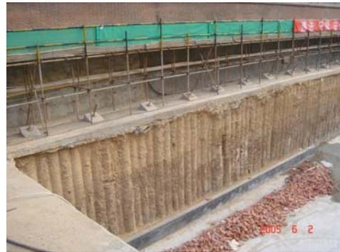
图 27-43 郑州天下城复合桩墙基坑工程
