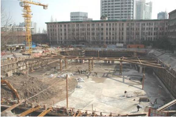
图 27-63 钻孔后注浆连续墙基坑工程开挖全景
