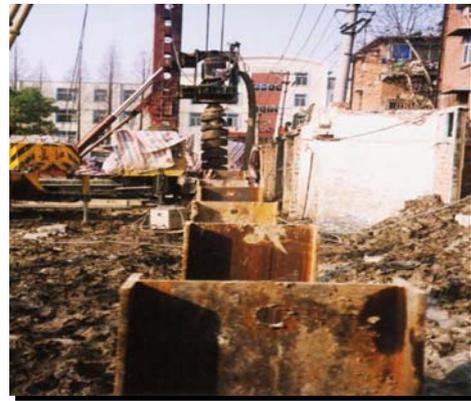
图 22-56 钻孔后注浆连续墙内插入 H 型钢
