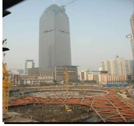
图 27-61 核心闹市区钻孔后注浆连续墙基坑工程实景
