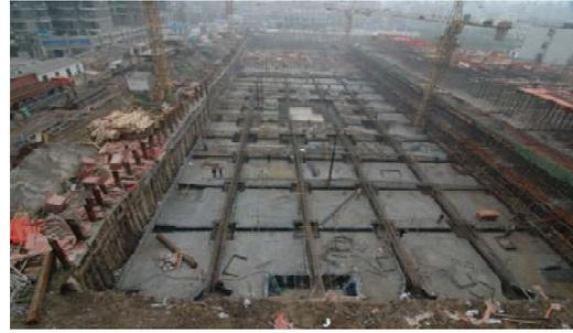
图 22-58 扶壁式钻孔后注浆连续墙工程实景
