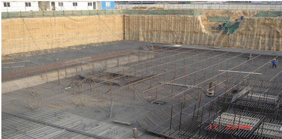
图 27-32 上海绿地郑州世纪峰会基坑工程采用复合桩墙支护
