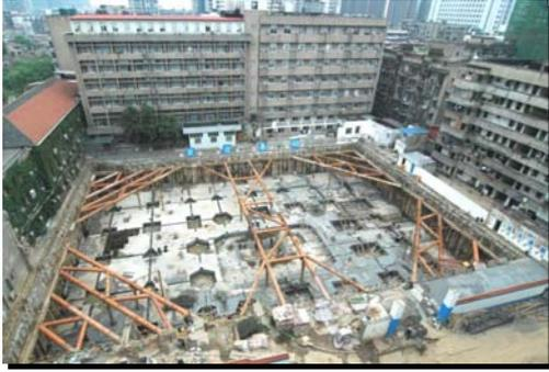
图 27-51 钻孔后注浆连续墙工程实景图
