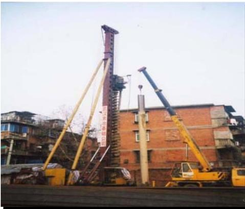
图 22-55 长螺旋钻机成孔
