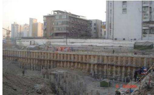
图 27-46 郑州国贸中心基坑工程复合桩墙锚支护实景
