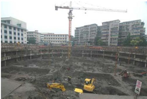
图 27-59 铁四院生产科研大楼钻孔后注浆连续墙
